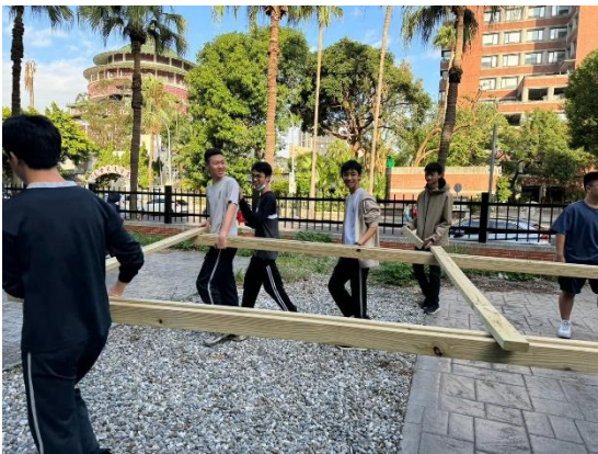
圖 7 基地立柱的製作
